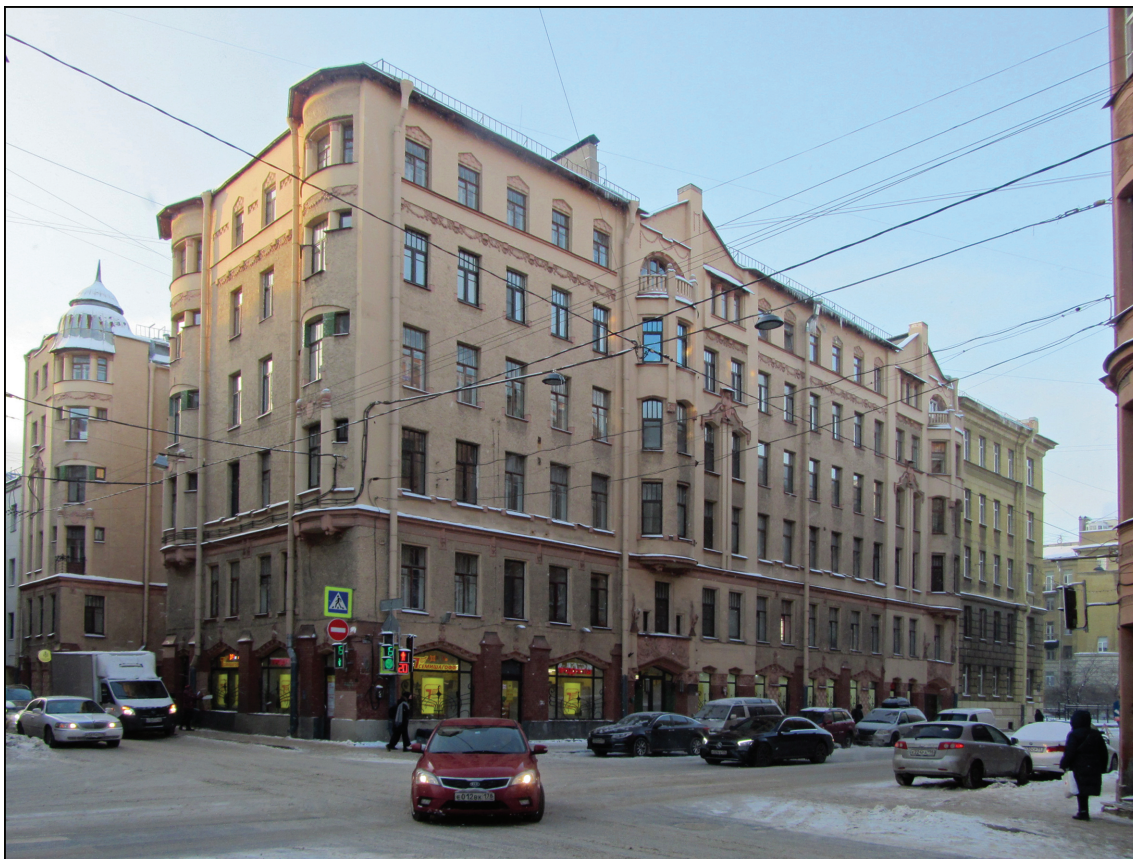
Дом И.Ф. Алюшинского. Малый проспект Петроградской стороны, 66 – ул. Ленина, 32. Фото М.В. Королёвой. Январь 2022 г.
