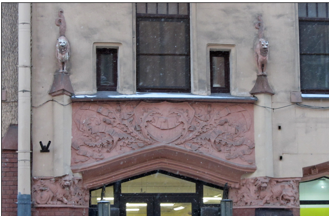
Лепной декор на фасадах дома И.Ф. Алюшинского. Фото М.В. Королёвой. Январь 2022 г.
