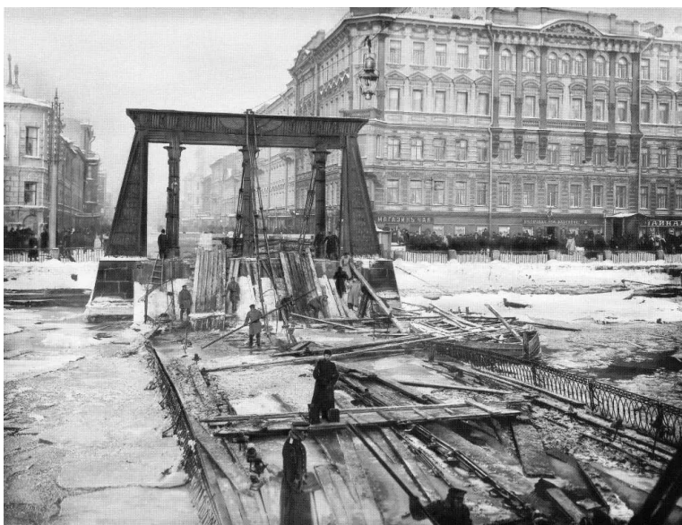
Рис. 9: Разрушенный Египетский мост
