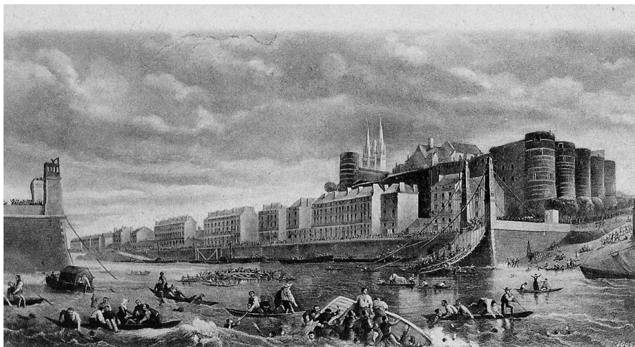
Рис. 8: Разрушенный мост Бас-Шен
