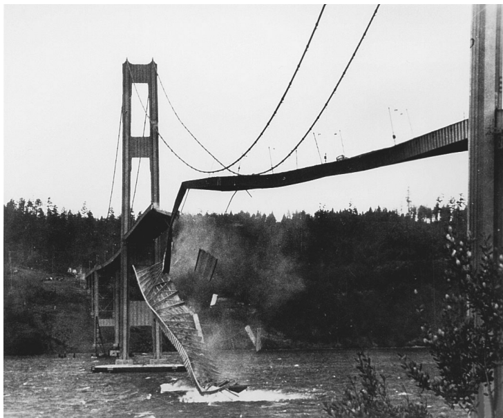
Рис. 10: Разрушенный Такоумский мост
